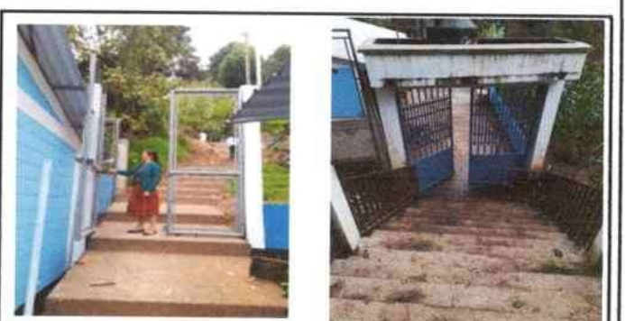
Foto 6: Ejecución de lijado y pintura de portones
