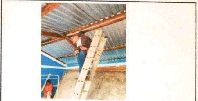
Foto 4: Colocacion de instalacion de energia electrica en la cocina.
