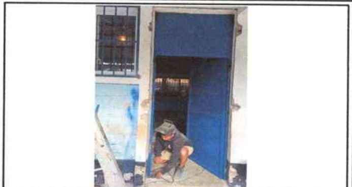
Foto 2: Cambio de ubicación, pintura y colocacion de chapa de puertas.
