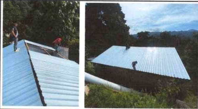
Foto 1: Colocacion de lamina troquelada
