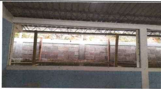
Foto 3: Instalacion de ventanas y balcones en aulas 1 y 2
