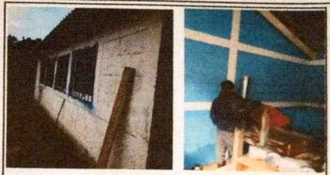
Foto 2: Sustitución de ventanas en la cocina e instalación de estufas rurales.
