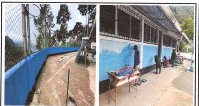
Foto 4: Ejecucion de pintura de muros interiores y exteriores
